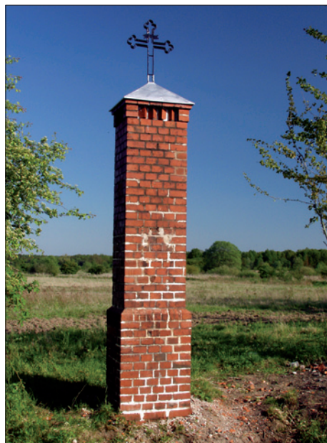
Ryc. 6. Przydrożny obiekt sakralny we wsi Stępień koło Braniewa
